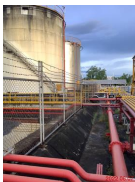
ภาพที่ 2-5 คันคอนกรีตสูง 1.00 เมตร ล้อมรอบลานถังเก็บน้ำมัน
